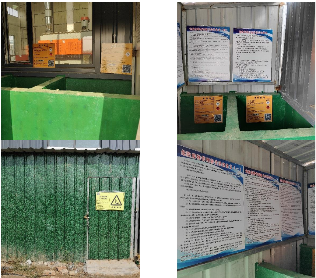
图 3-2 危废暂存间现状图
