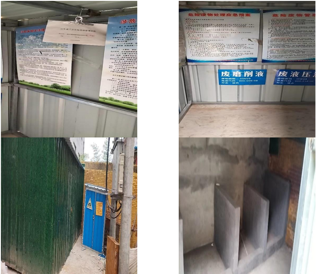
图 3-2 危废暂存间现状图
