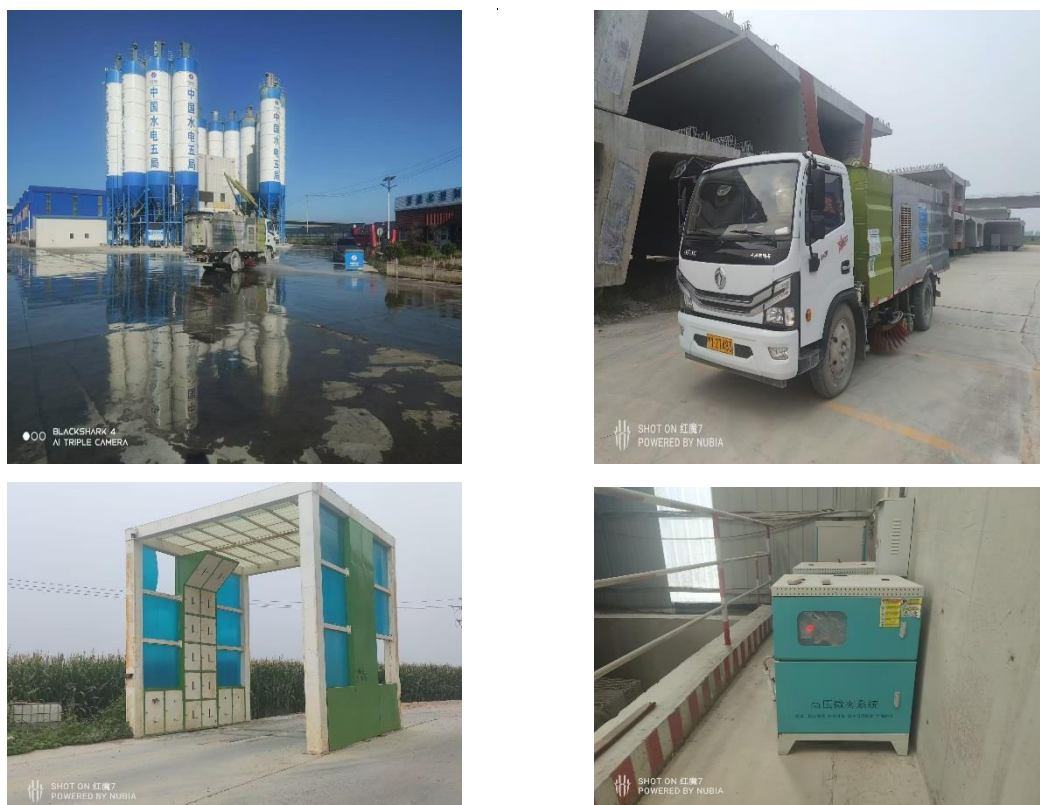
图 3-1 厂区内抑尘处理设施
