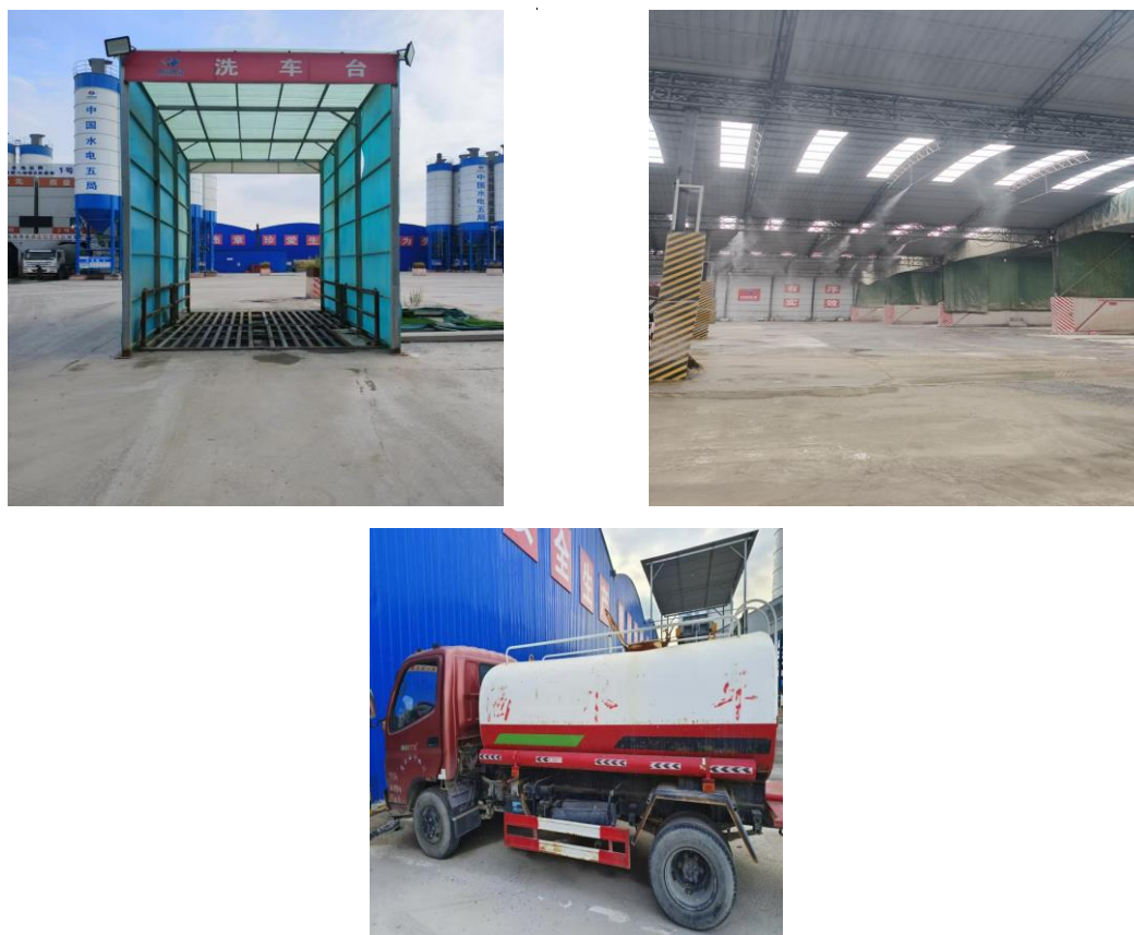
图 3-1 厂区内抑尘处理设施
